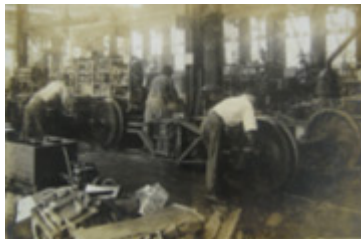
⬇ 大連市沙河口満鉄鉄道工場 組立工場
