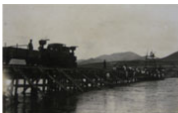
NEW 東部国境 東寧付近 復旧作業ト軽便ノ運転
